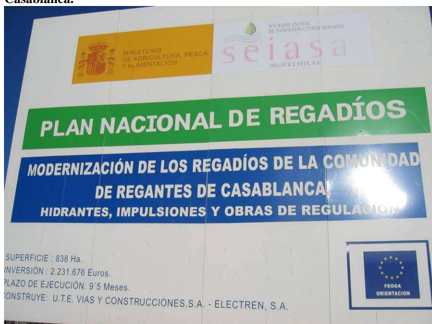
Figura 22. Obras del Plan Nacional de Modernización de regadíos en la comunidad de regantes de Casablanca.
